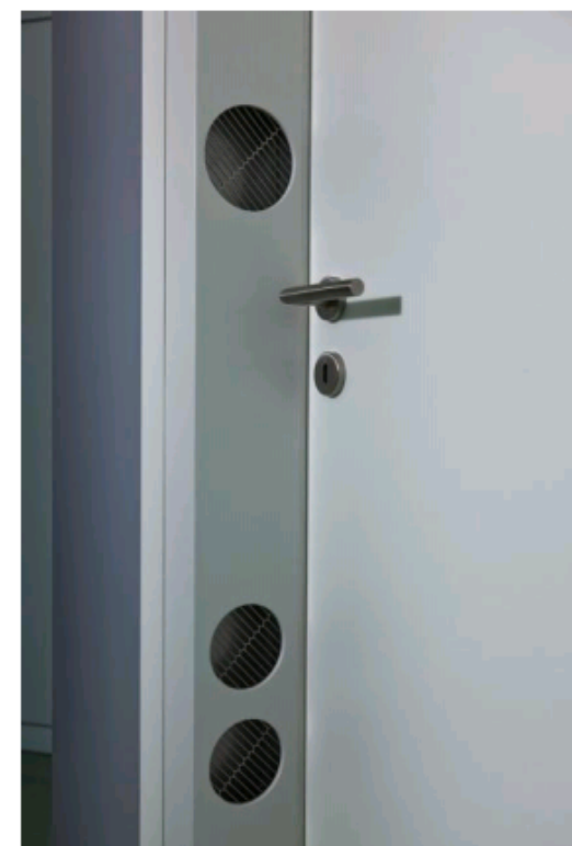
Compensatore con ventilatori inserito nella mazzetta
